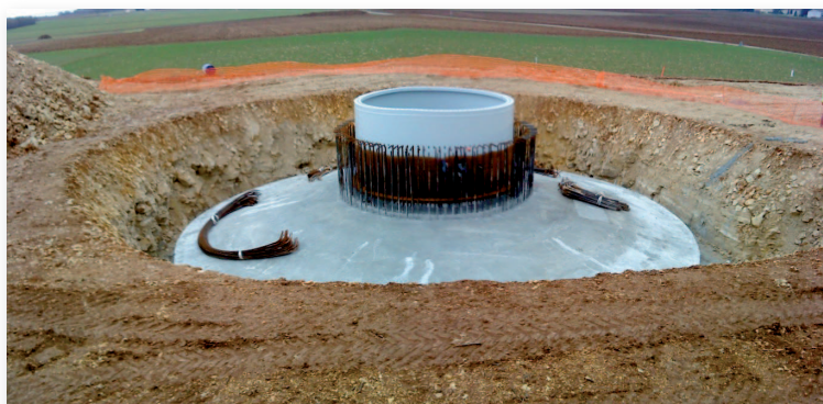
La fondation en cours de bétonnage
